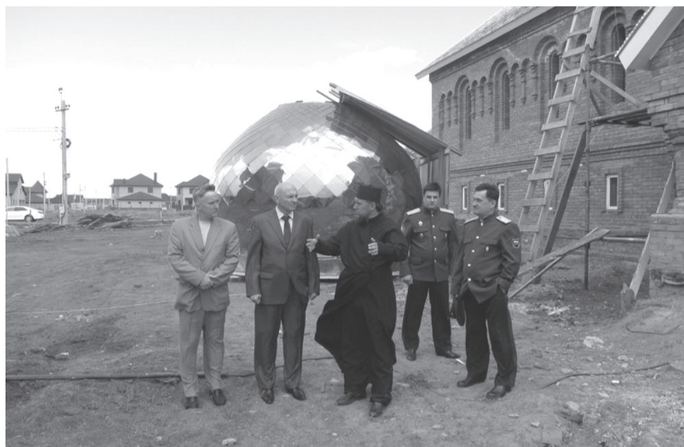
На месте строительства
